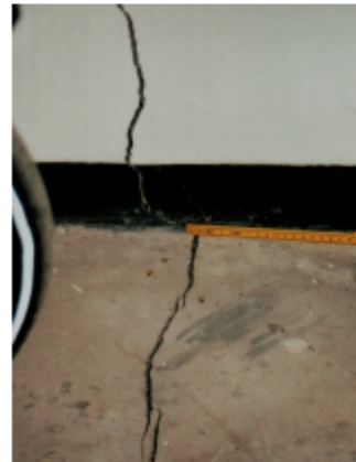
Beispielhafte Risse in Wänden und Böden durch bergbauliche Bodenbewegungen.
