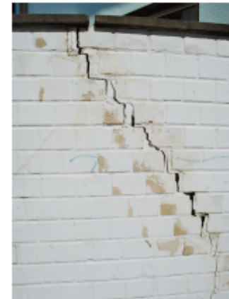
Beispielhafte Risse in Wänden und Böden durch bergbauliche Bodenbewegungen.
