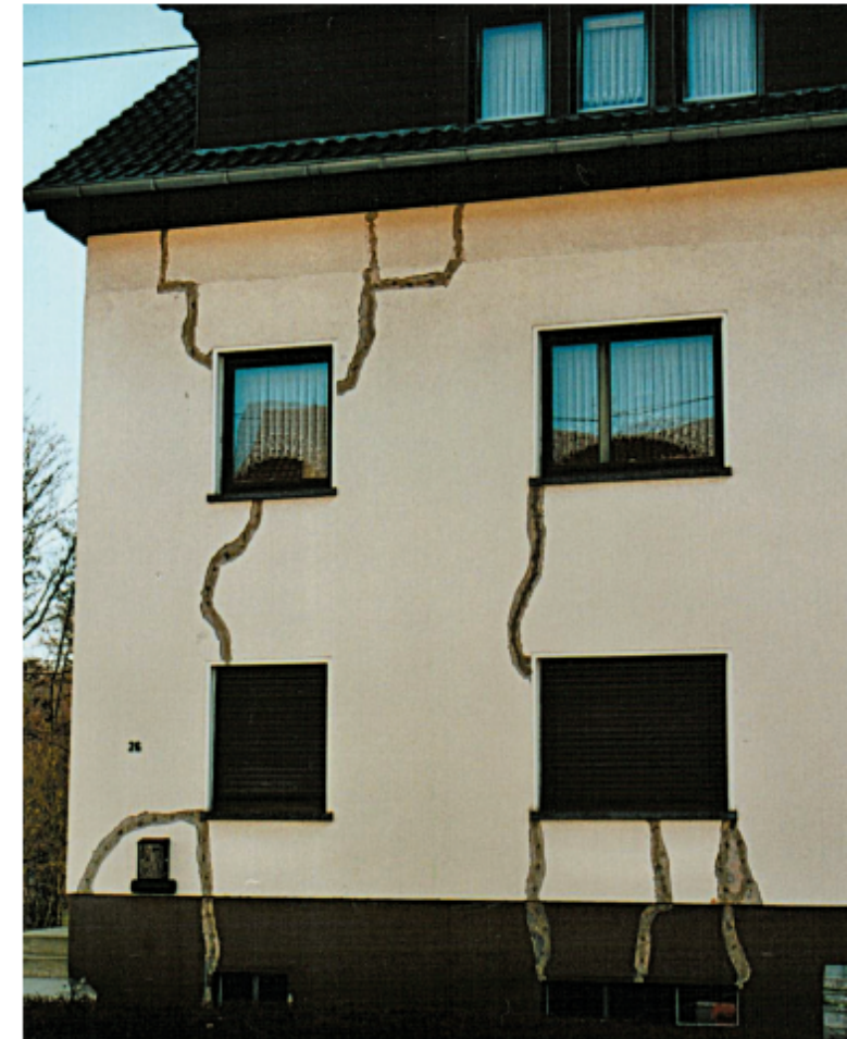
Beispielhafte Risse in Wänden und Böden durch bergbauliche Bodenbewegungen.
